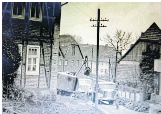
Historisches Foto vom Ausbau der Sankt Georgsstraße.
